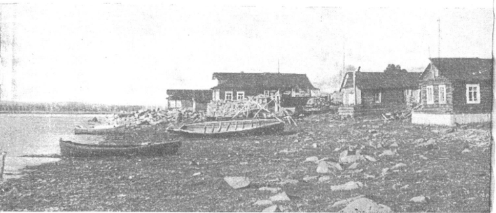
Ваготовка и сушка досок для строительства лодок
